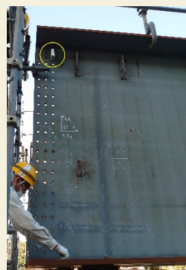
製造・建設現場 組立作業・検査
