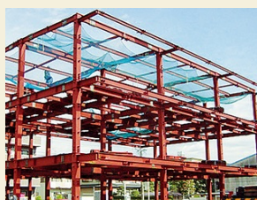
土木・建設・製造現場
