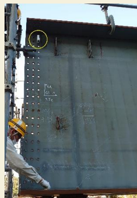
製造・建設現場 組立作業・検査
