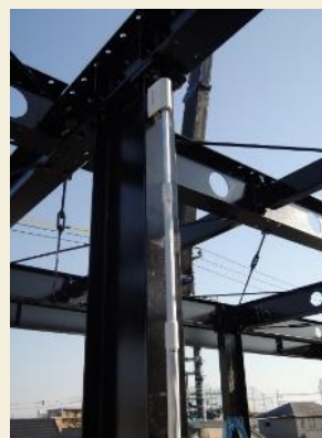
建築現場でのクイックハンド使用例
